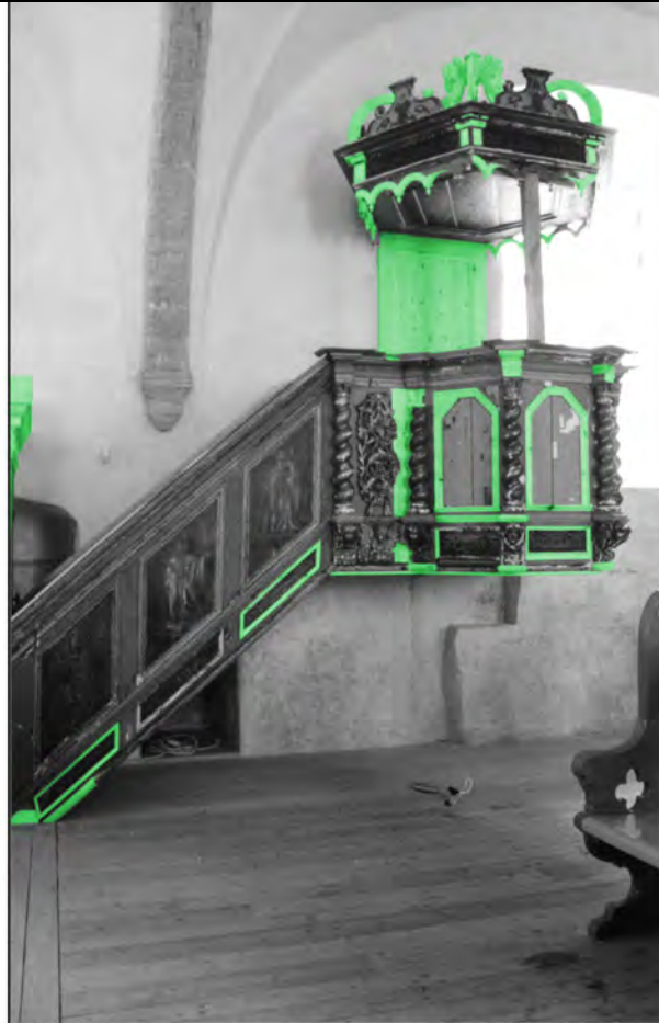
2000-2002. aastate restaureerimistöõde käigus rekonstrueeritud kantsli osad markeeritud rohelisega. Allikas: Ennistuskoda "Kanut" aruanne
