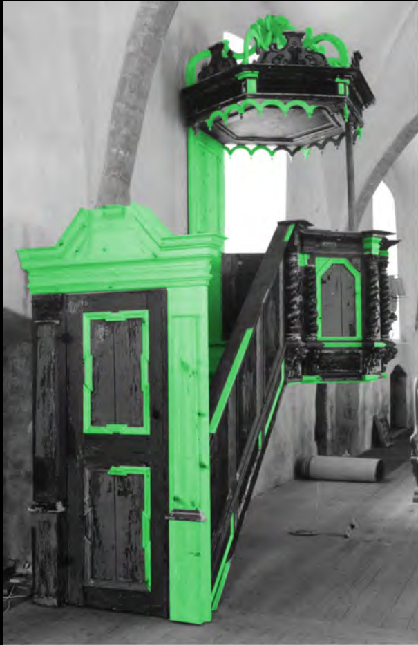
2000-2002. aastate restaureerimistöõde käigus rekonstrueeritud kantsli osad markeeritud rohelisega. Allikas: Ennistuskoda "Kanut" aruanne
