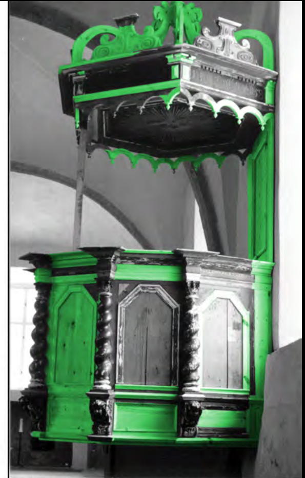
2000-2002. aastate restaureerimistöõde käigus rekonstrueeritud kantsli osad markeeritud rohelisega. Allikas: Ennistuskoda "Kanut" aruanne
